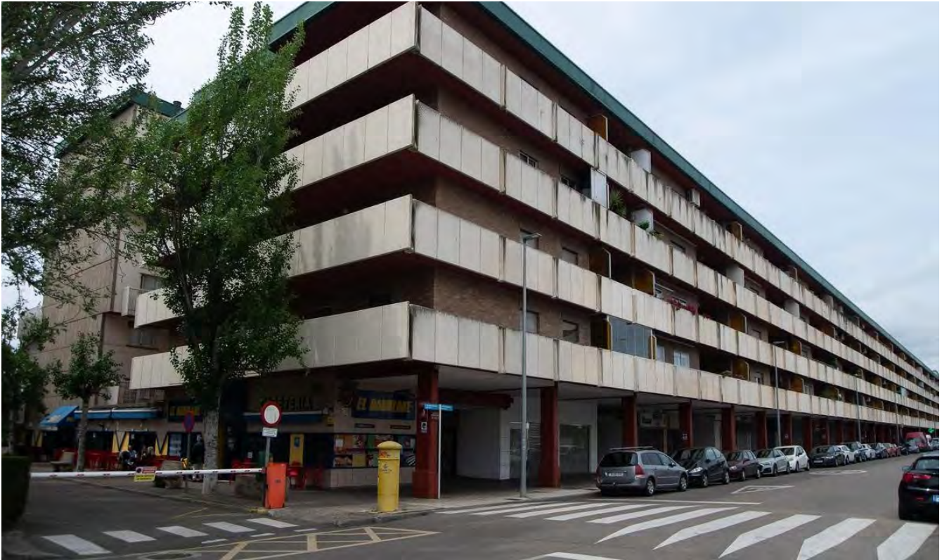
En la calle Silveria Fañanás de la Urbanización Torres de San Lamberto hay locales comerciales y otros servicios públicos.
