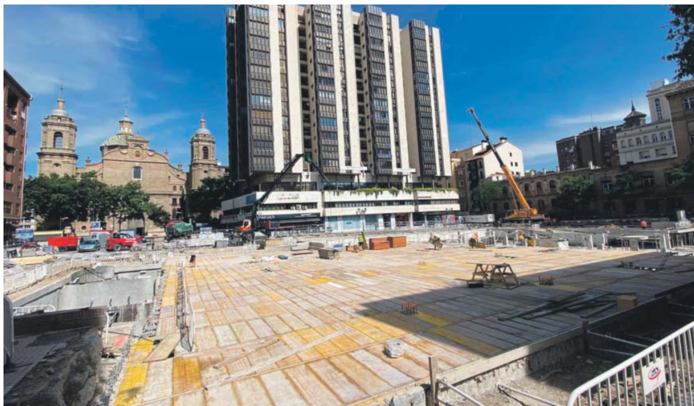
Las obras de la plaza Salamero avanzan a buen ritmo.
