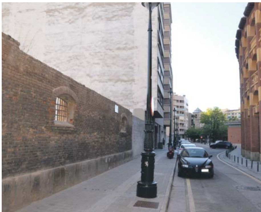
El muro del antiguo Cuartel de Caballería podrá recuperarse, ponerse en valor y quedar integrado en el proyecto de viviendas del entorno.
