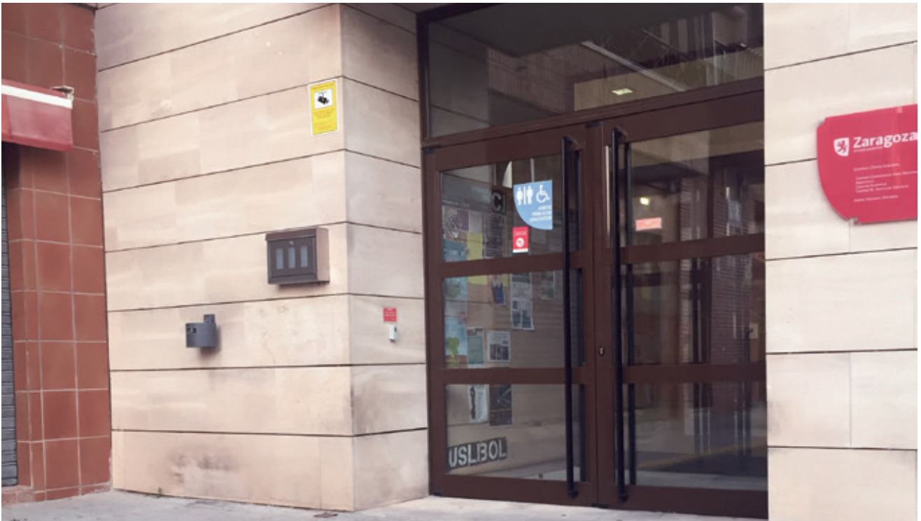
Rebaje de la acera solicitado a la entrada del centro cívico de Juslibol.
