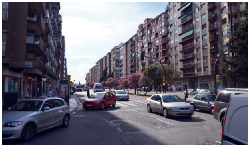
En las aceras de la avenida de Navarra hay deficiencias importantes.
