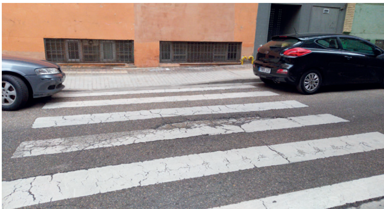
Las deficiencias en la pavimentación se señalan en varias calles y pasos peatonales del distrito.
