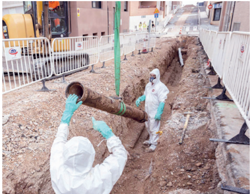
Se están acometiendo obras de mejora en las tuberías de saneamiento de Delicias y El Rabal.
