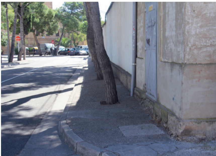
En el camino Puente Clavería las aceras son muy estrechas y el tránsito es complicado.
